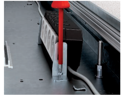
Szerelvények hely és modul tartó beszerelése csatorna alsó részbe Az installációs szerelvények csatlakoztatása után szerelje fel a szerelvénytartókat a modul tartókra vagy szerelvénykelyhekre. A komplett egységet fixen csavarozza be a csatorna alsó részbe.
